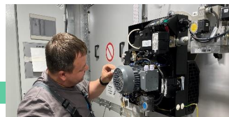
Монтаж и пуско-наладка
